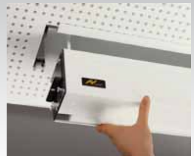
Servicefreundliche Montage der Bildwand nach Beendigung der Bauarbeiten.
